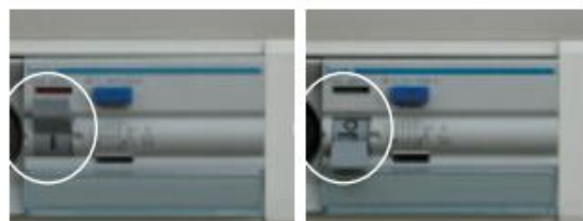
Når "I" er synligt, er installationen tilkoblet, og når "0" er synligt, er installationen afbrudt.
